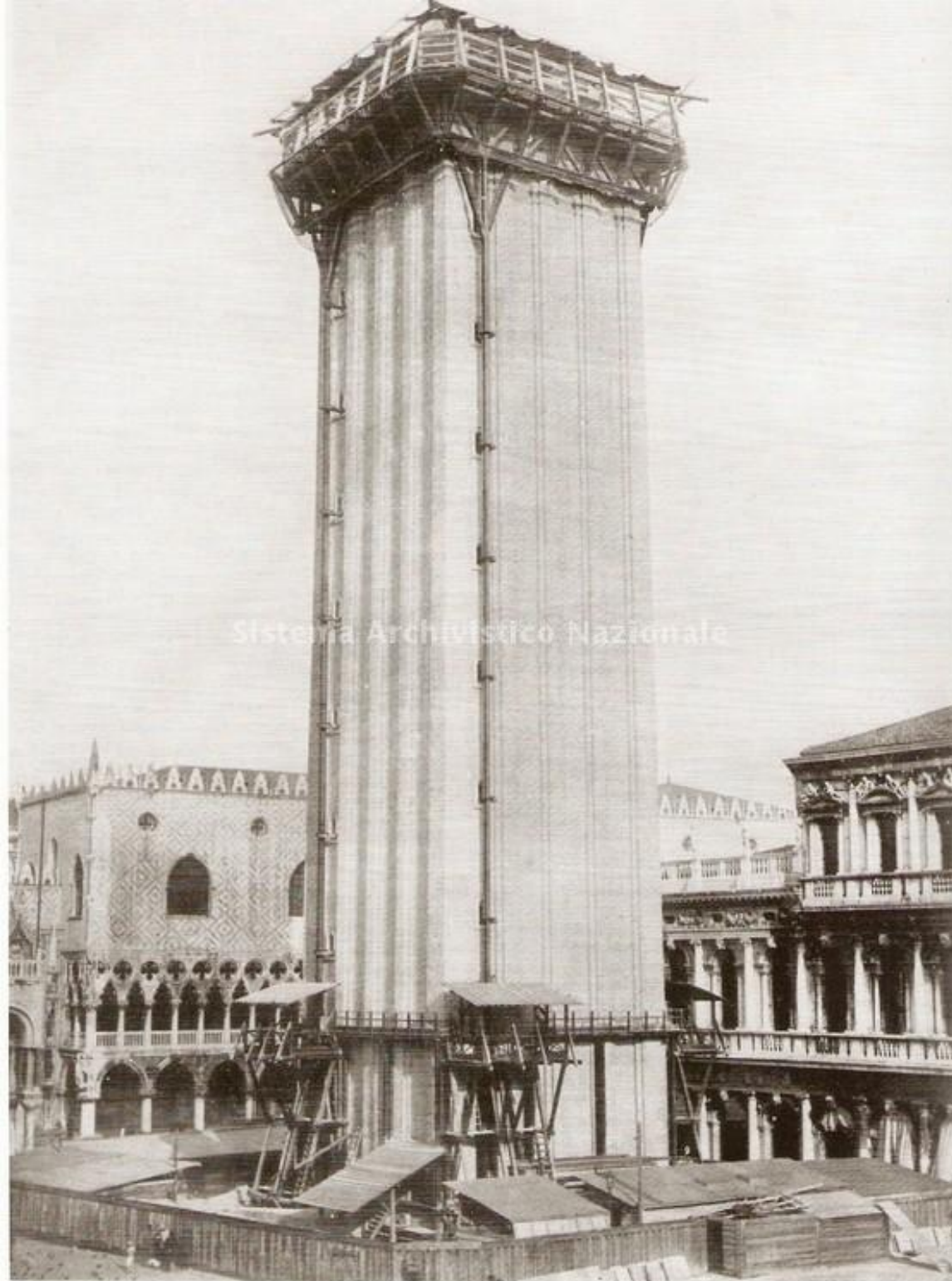
Il campanile di S. Marco in costruzione, con l'armatura del Donghi
